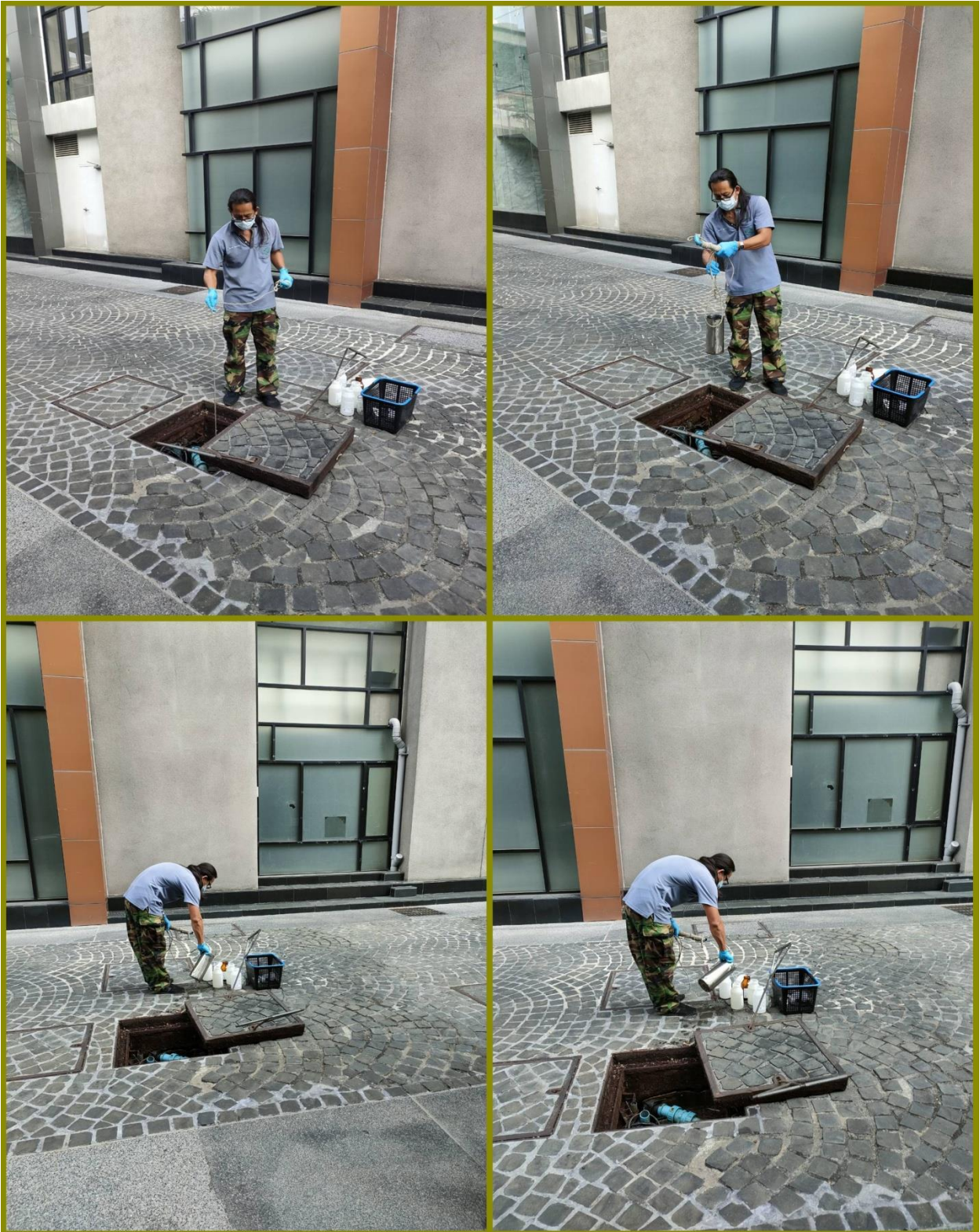
รูปที่ 38 รูปเก็บตัวอย่างน้ำเข้าระบบบำบัดน้ำเสีย
